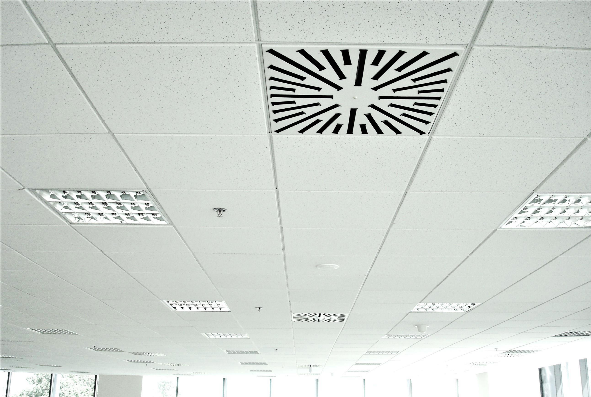
Trần Sợi Khoáng Tấm USG IMPRESSION + Khung USG DXM – Tòa Nhà A&B
