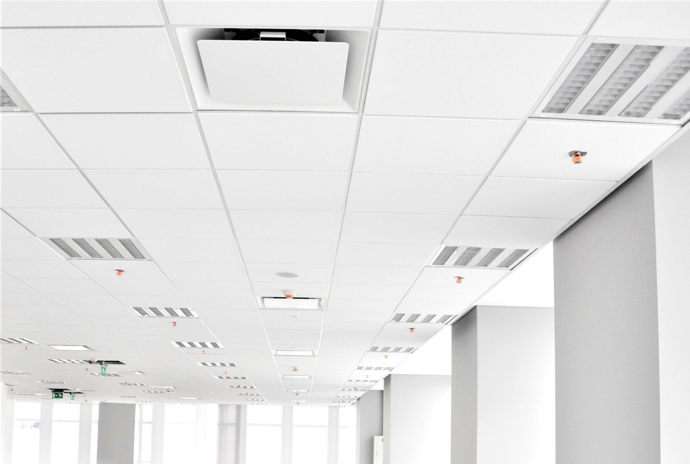
Trần Sợi Khoáng Tấm USG OLYMPIA + Khung CMC T15 – Tòa Nhà VIETCOMBANK
